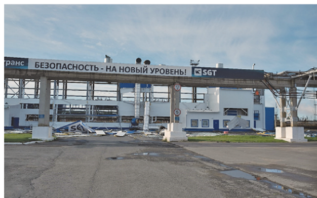
Рис. 34. Взрыв газовоздушной смеси при проведении АО «СГ-Транс» работ по проверке железнодорожной цистерны на герметичность
