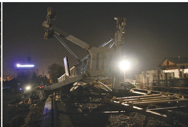
Рис. 53. Угон ветром подъемного сооружения и его падение на площадке строительства
