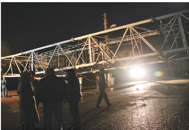
Рис. 53. Угон ветром подъемного сооружения и его падение на площадке строительства
